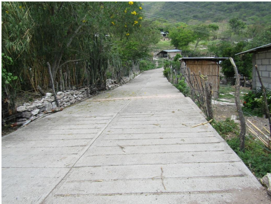
Figura 62. Servicios públicos básicos de Totolzintla (Calle pavimentada).
