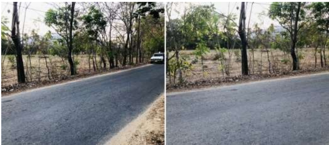
ILUSTRACIÓN 14. ACCESO AL BANCO DE ALMACENAMIENTO (Km. 0+970 DE LA CARRETERA SAN LUIS ACATLÁN - EL CARMEN )
