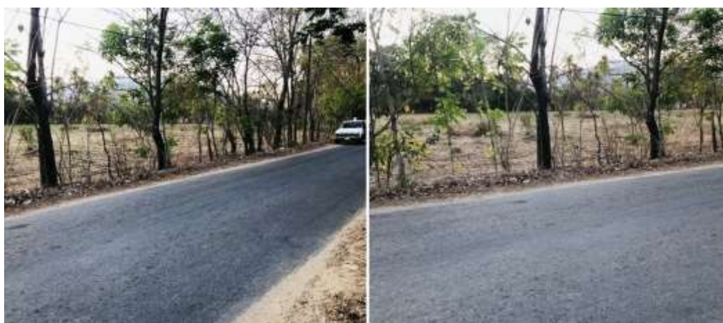
ILUSTRACIÓN 51. ACCESO AL BANCO DE ALMACENAMIENTO (KM. 0+970 DE LA CARRETERA SAN LUIS ACATLÁN - EL CARMEN )
