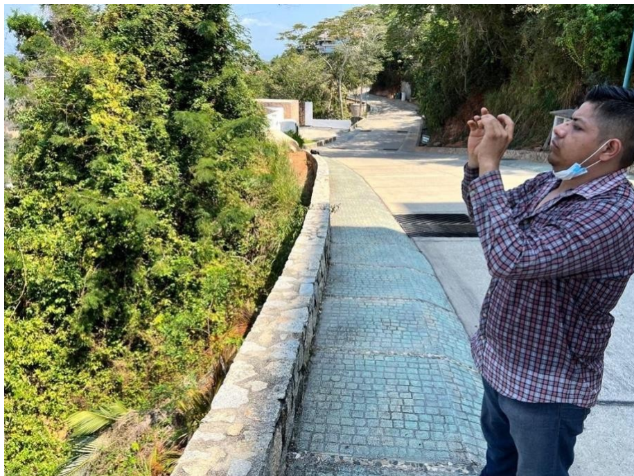
Imagen 5. Colindancia Norte se ubica Vialidad Paseo de la Bahía.
