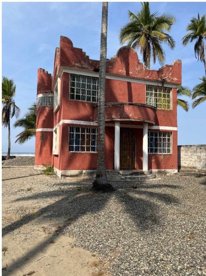
Dentro de las construcciones existentes a demoler, está la Casa 5. Esta se sitúa en el límite al sureste del predio, frente a la playa.
