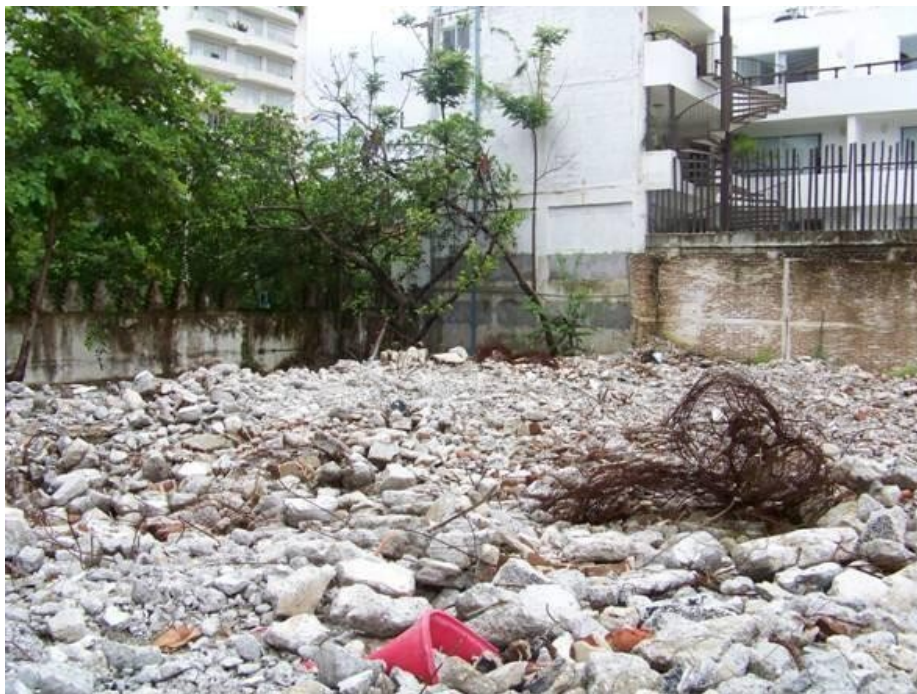
Figura IV.35 Escombros y basura depositados en algunas áreas del predio.
