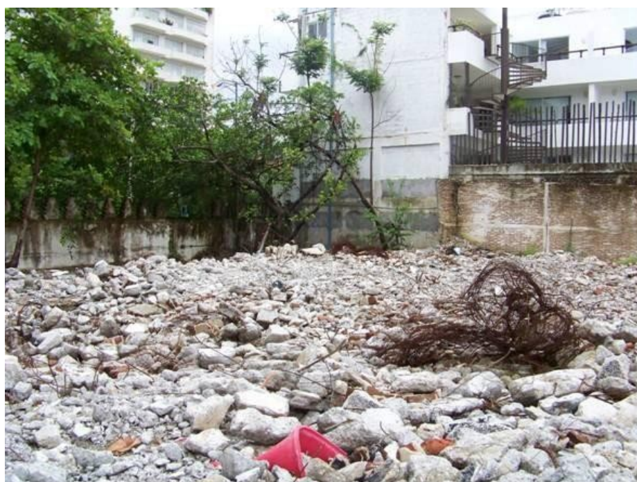
Figura VI.7 Escombros y basura depositados en algunas áreas del predio.
