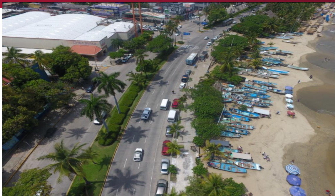
Fotografía. Panorámica del área del proyecto donde se puede apreciar la vegetación del estrato arbóreo.
