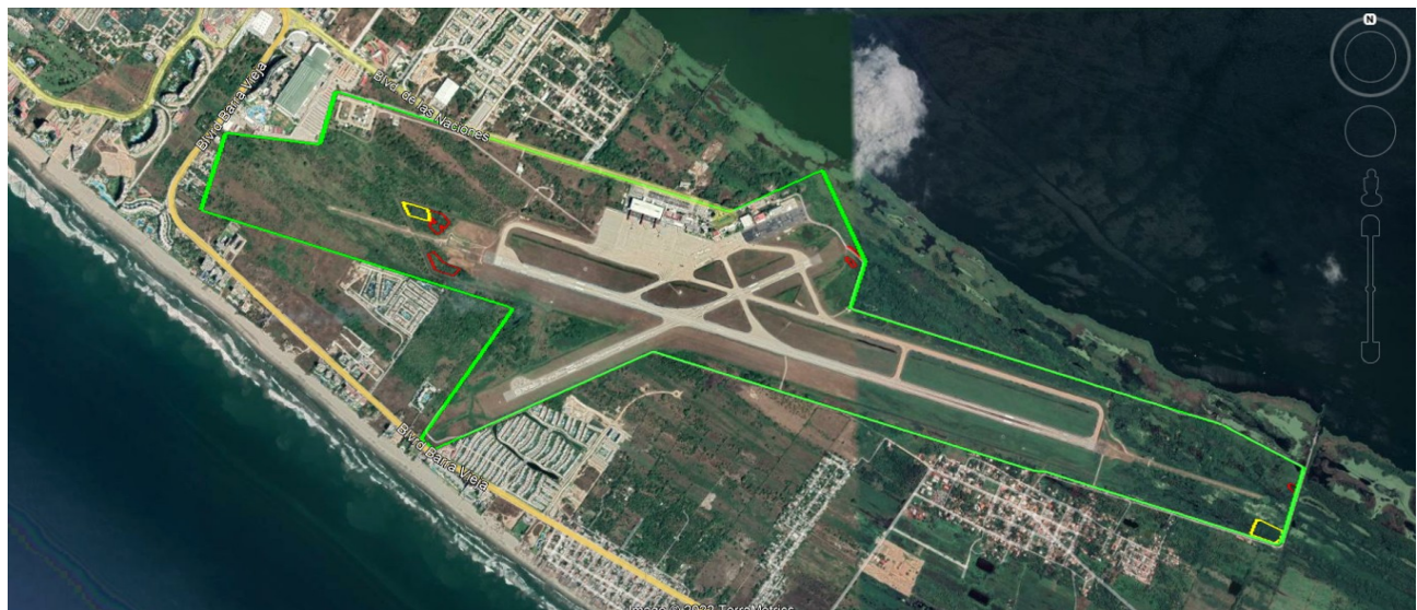
Imagen 03. Presenta una imagen en retrospectiva del estado de la vegetación en el año 2003 observando claramente la misma superficie en su mayoría desprovista de vegetación lo que indica que con antelación se daba mantenimiento a dicha zona.
