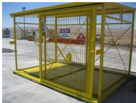
Imagen. Ejemplo de un almacén temporal para residuos peligrosos.
