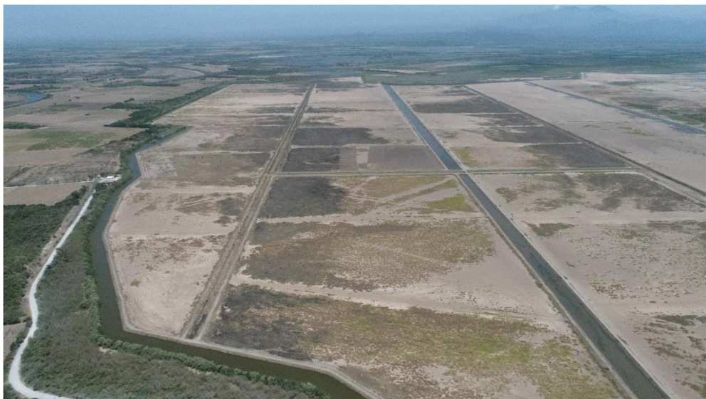
Figura II.5. fotografía que muestra el espacio de terreno que se utilizará para el proyecto.
