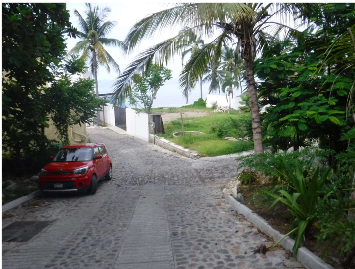
FIGURA II. 8 ACCESO POR LA VIALIDAD COLINDANTE AL NORTE
