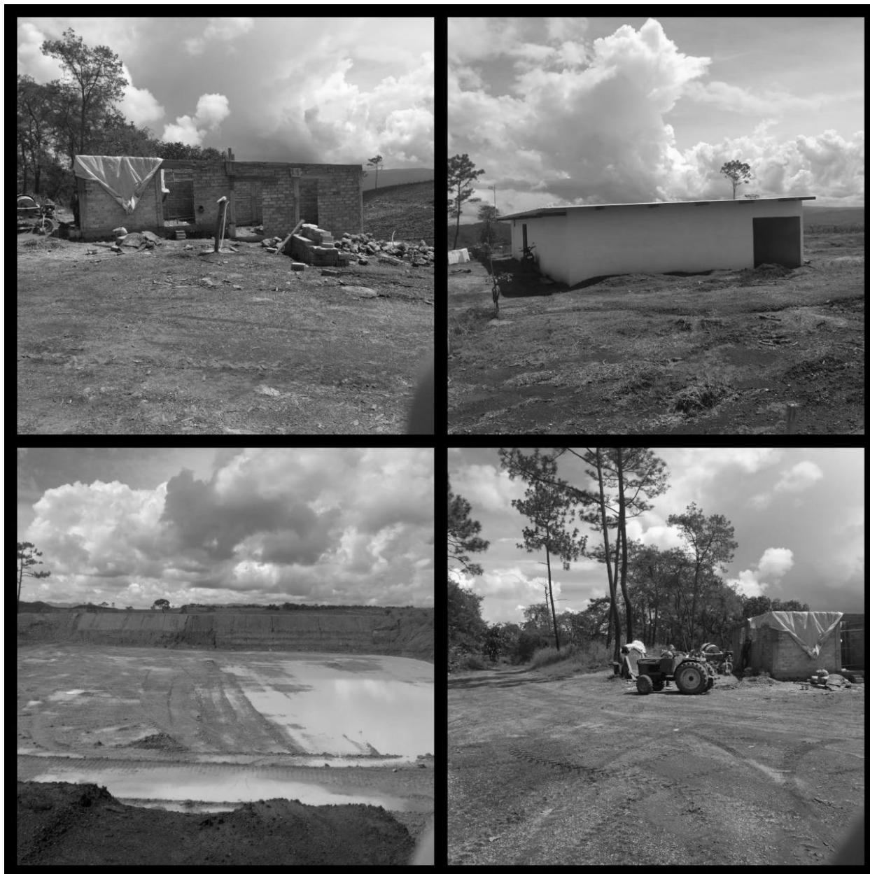
Obras realizadas en la Huerta el Ocotillo, Santa María del Oro, Nayarit.
