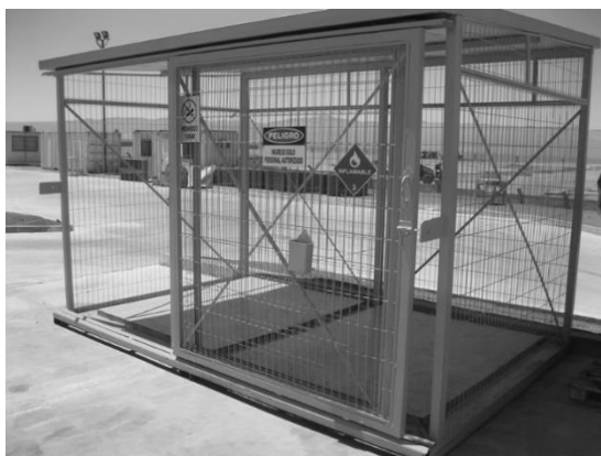
Ejemplo de un almacén temporal para residuos peligrosos.
