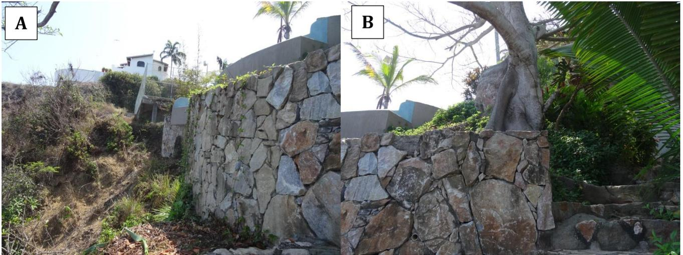
Figura II-15. Muros de contención hecho de mampostería ubicados en límite Noreste del terreno. A). Sirve de asiento a la alberca. B) De forma semicircular, funciona como jardinera de una higuera de gran tamaño que se localiza en el límite del terreno.
