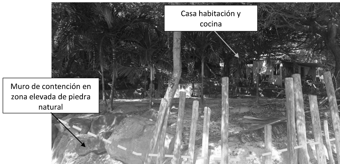
Imagen II.15 Superficie en zona alta en la cual las obras existentes se soportan de un muro de contención de piedra y troncos tipo postes de madera rústicos
