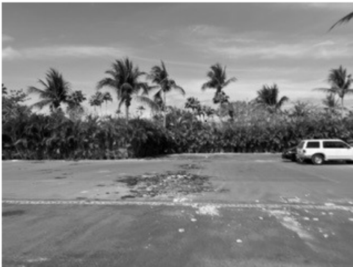
Fig. IV.38 Estado actual de las canchas de tenis en el sitio en donde se construirá el proyecto.
