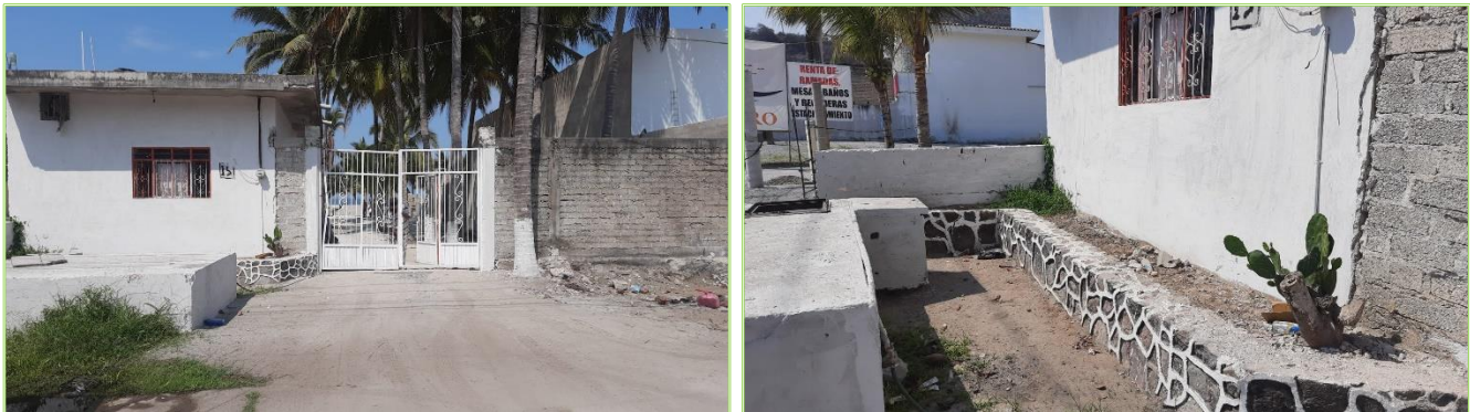
Imagen II.4 Instalaciones existentes por demoler
