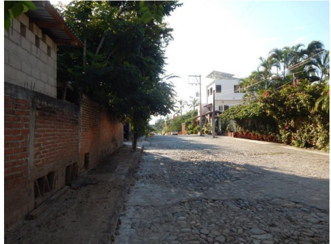
Vista de la colindancia sur del predio con la Calle Francisco I. Madero
