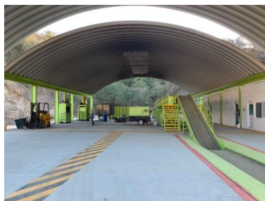
Planta de separación y compactación de plásticos
