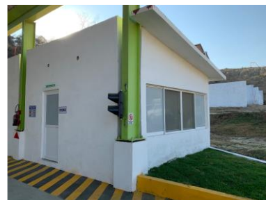
Oficinas administrativas de las nuevas instalaciones
