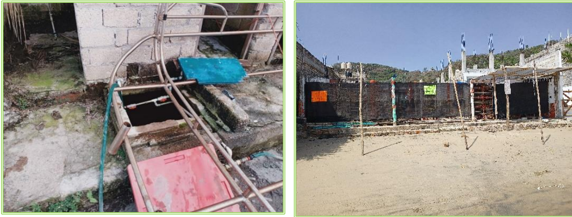
Imagen II.7 Instalaciones existentes por demoler
