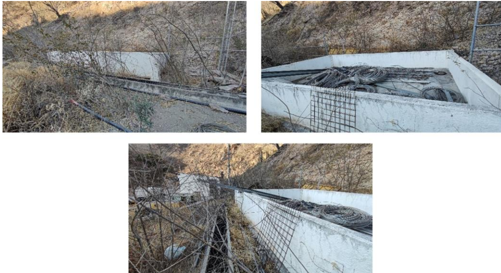
Figura II.11. Vistas de la estructura de mampostería utilizada para almacenaje de pedacería de cable.
