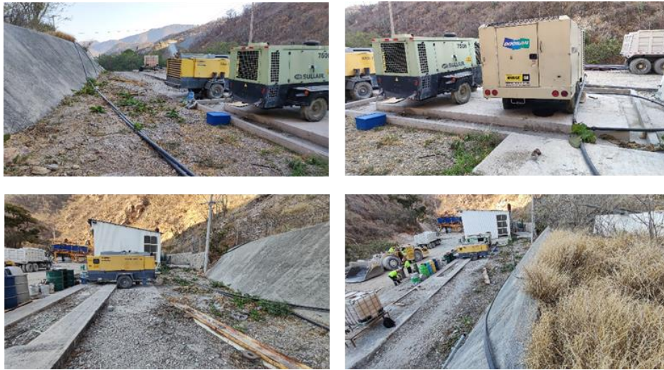
Figura II.4 Proceso de instalación de la plancha de concreto.
