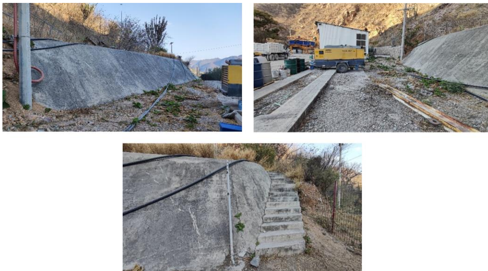
Figura II.10. Vistas del muro de contención (de mampostería) existente en zona de Proyecto.
