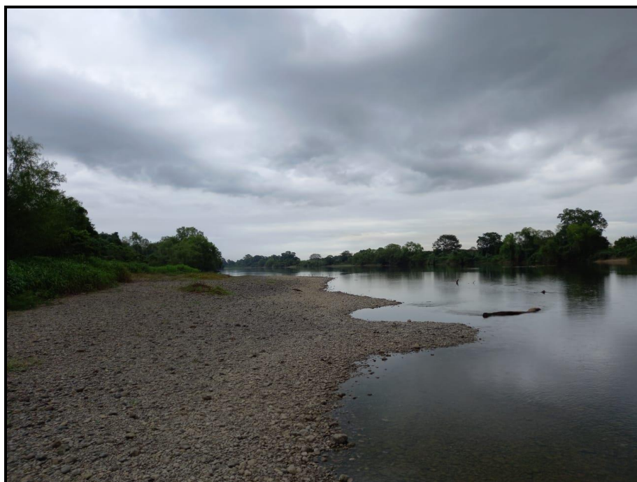
Fotografía 2. El proyecto permitirá el encauzamiento del río Papaloapan; nótese en la margen izquierda las afectaciones que han sufrido los predios en años anteriores a causa del crecimiento de la creciente del río por el abundamiento de materiales pétreos en la zona.
