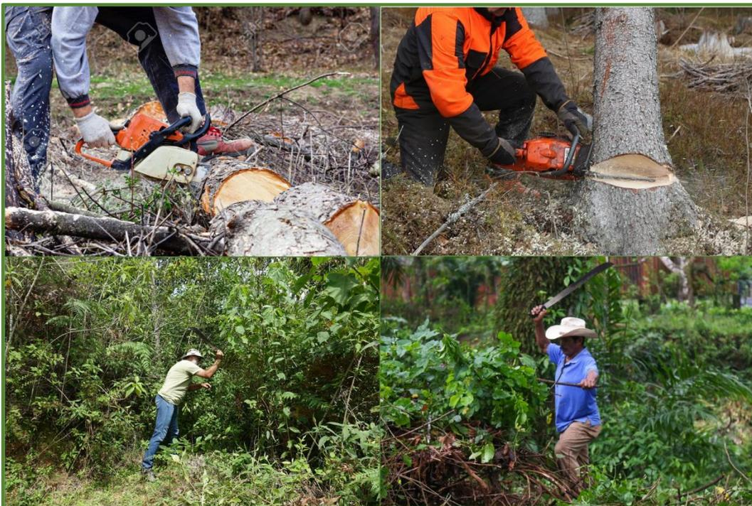
Ilustración II-26 ejemplo del desmante con Motocierra y Machete
