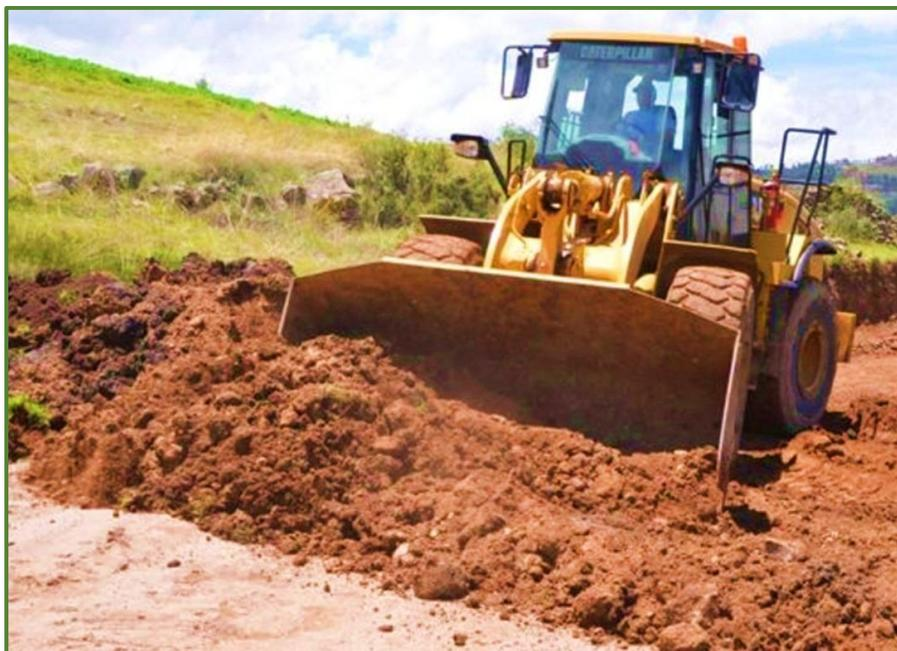
Ilustración II-27 ejemplo del Despalme del terreno, remoción de capa orgánica vegetal
