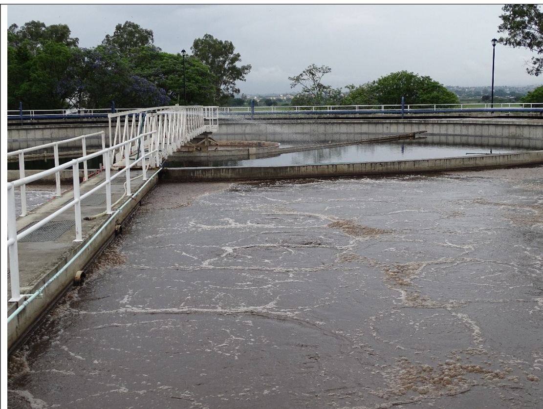
Fotografía donde se aprecia uno de los brazos superiores del sedimentador
