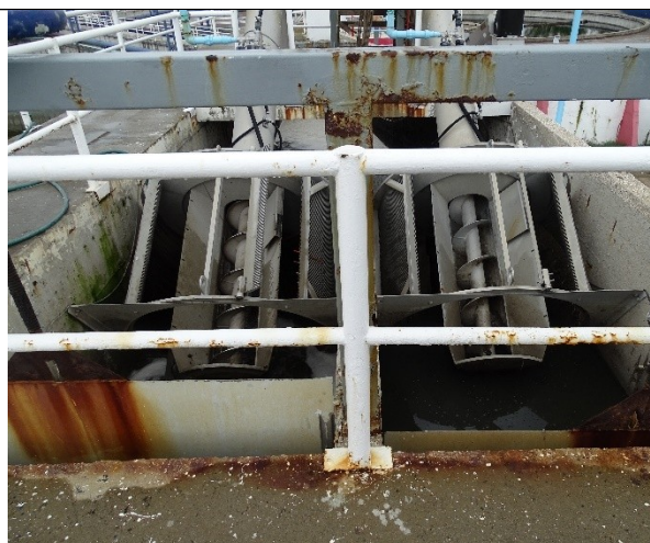
Cribas automáticas en las cuales pasa el agua residual.
