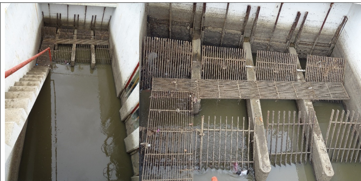
Fotografías de las rejillas donde el agua residual atraviesa para retener los residuos sólidos.
