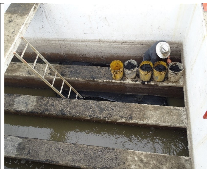
Fotografías en donde se observa la limpieza que se realiza a los canales, misma que se efectúa de manera manual, asimismo, se observa el conducto que dirige el agua residual al cárcamo de rebombeo.
