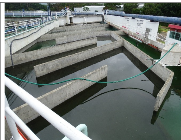
Fotografía del laberinto donde se adiciona el hipoclorito de calcio.
