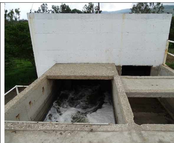
Llegada del agua residual al área de pretratamiento del complejo de la ptar.
