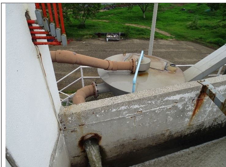
Desarenador tipo vortex
