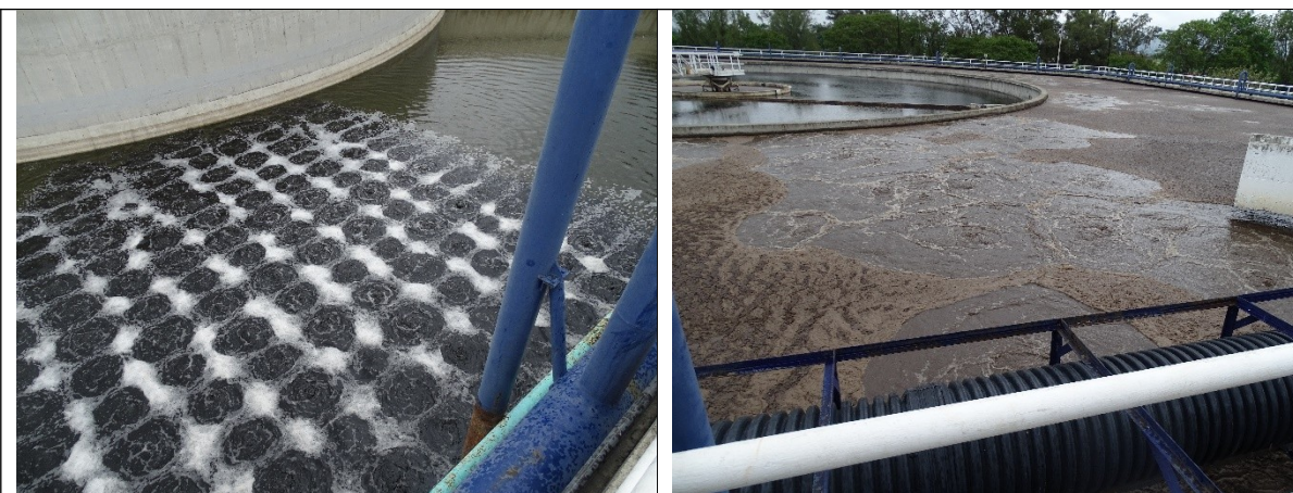
Fotografías en donde se observa la operación de los difusores de aire
