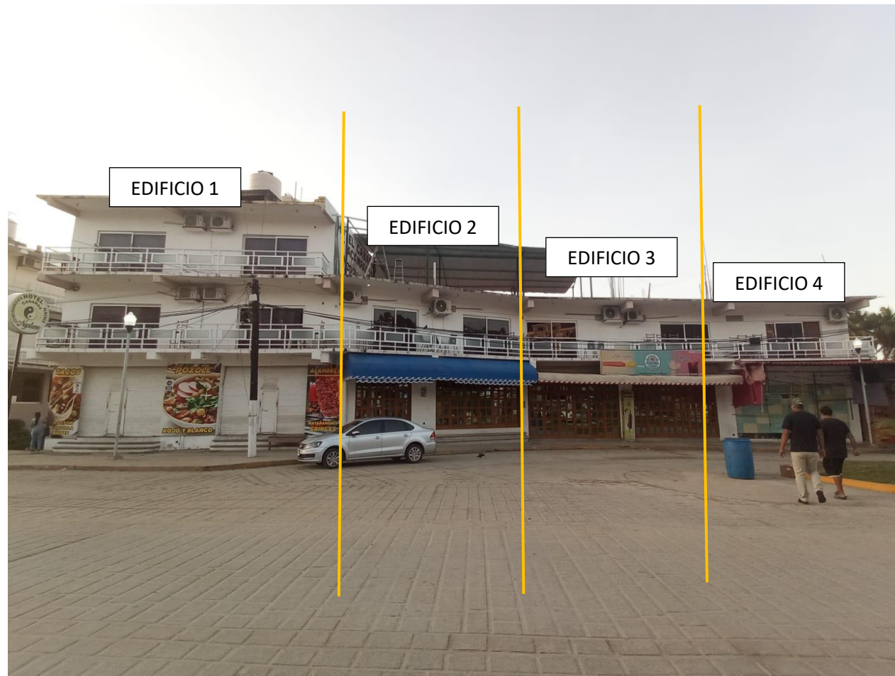
Figura II. 4. Imagen de las obras sancionadas por la PROFEPA.
