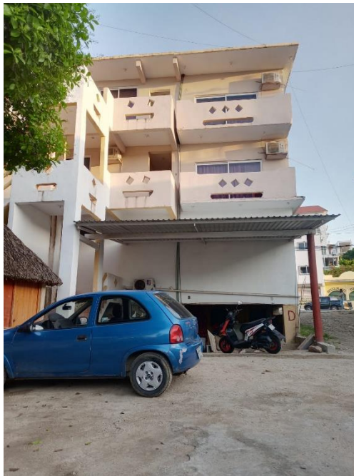
Figura VIII.3 Edificio 1 y cubo de escaleras.
