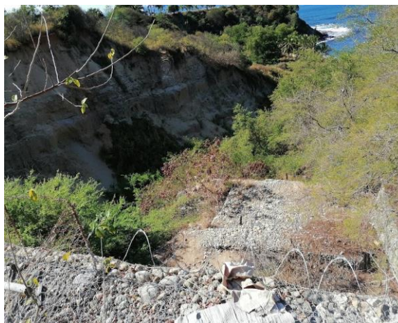
Imagen 2 Barranco formado durante las lluvias del huracán Carlota y obra de retención de suelos elaborada por el ejército mexicano.
