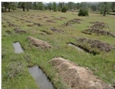
Zanja trinchera (tina ciega)
