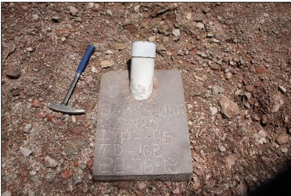
Figura 4. Imagen ilustrativa del sellado de barrenos.
