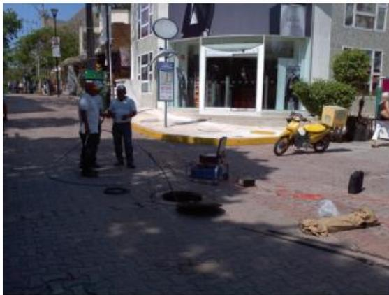
c) Cámara dentro de la red de alcantarillado
