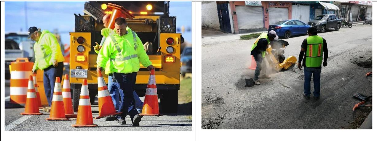
Fotografías ilustrativas enfocadas a la delimitación del área de trabajo, limpieza y trazo del sitio donde irían la tubería e incluso se observa acciones de corte del pavimento.
