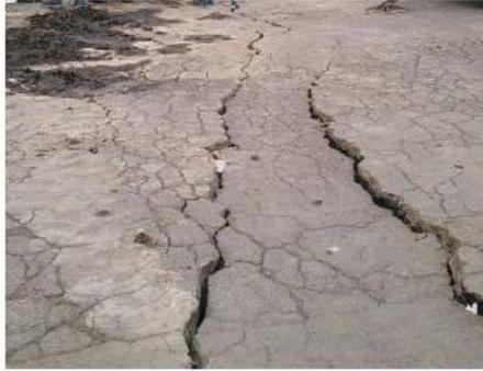
a) Hundimiento sobre tubería
