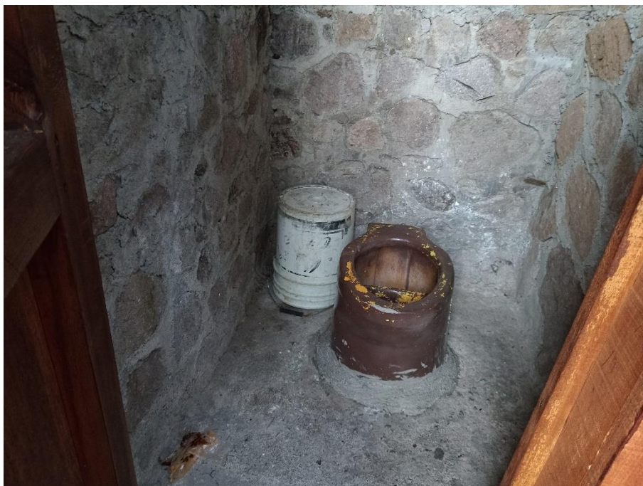
Imagen 28. El tipo de sanitario es de baños secos, no hay descargas al suelo o cuerpos de agua.
