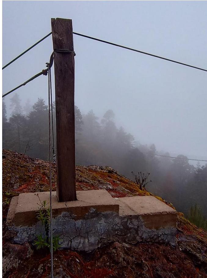
Imagen 35. Llegada de la tirolesa con poste de madera y base de concreto sobre la roca.
