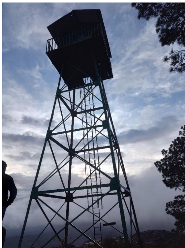
Imagen 18. Torre metálica que sirve para observación.
