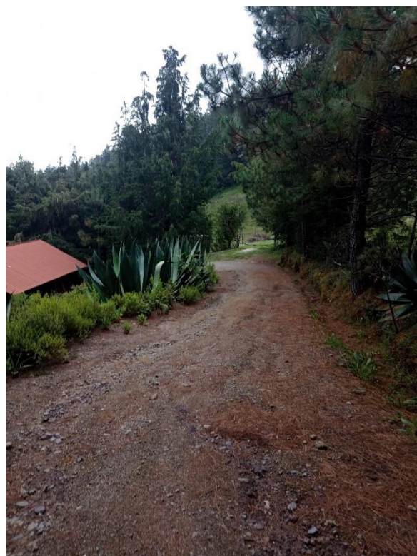
Imagen 20. Camino de terracería construido en la década de los 60's.
