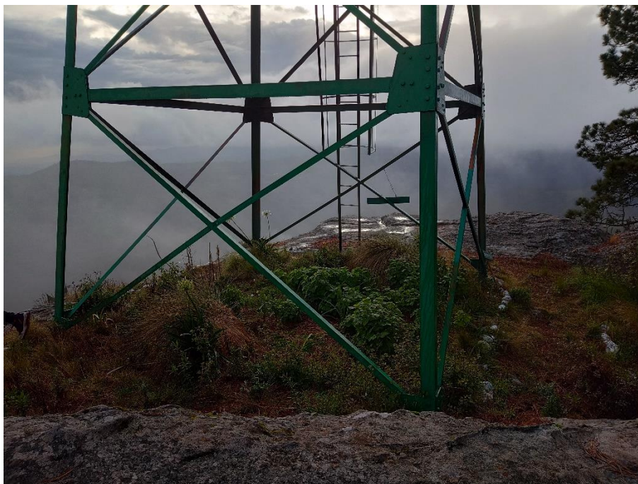
Imagen 17. Base de la torre metálica sobre roca
