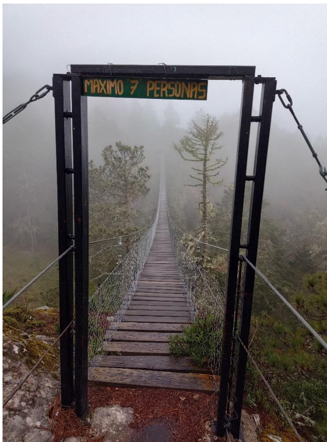
Imagen 29. Puente colgante de madera y protección de malla.
