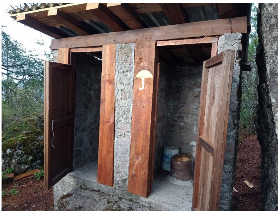
Imagen 26. Sanitarios existentes a base de mampostería y madera.
