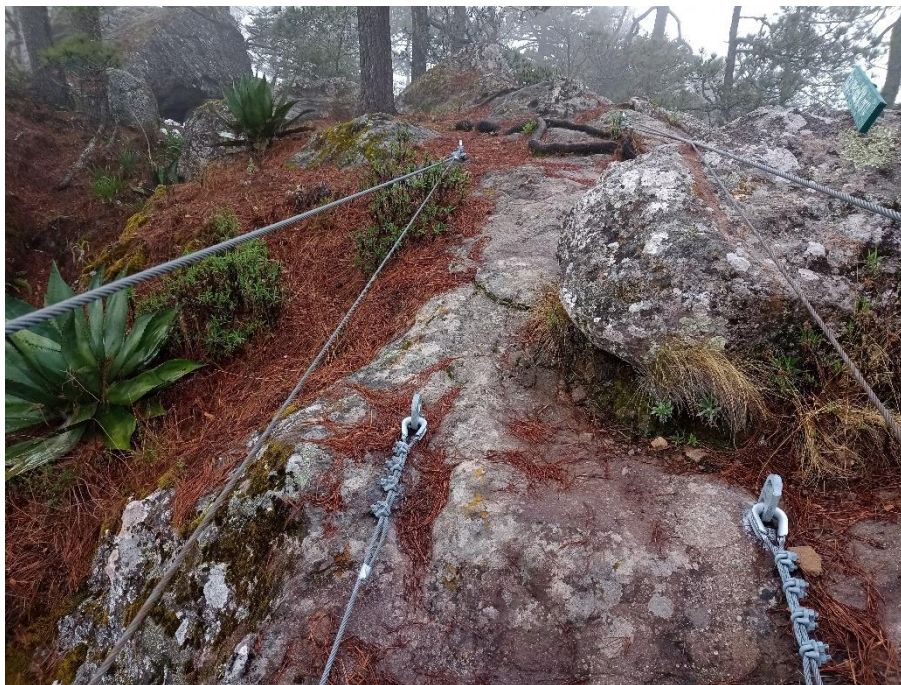
Imagen 30. Anclajes metálicos realizados sobre la roca.
