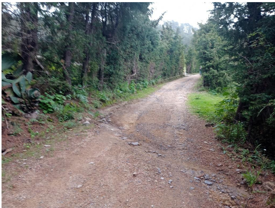
Imagen 21. Vista general del camino de un solo carril y de terracería.
