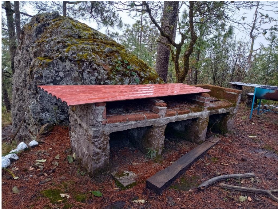
Imagen 24. Asador construido con piedra y cemento.
