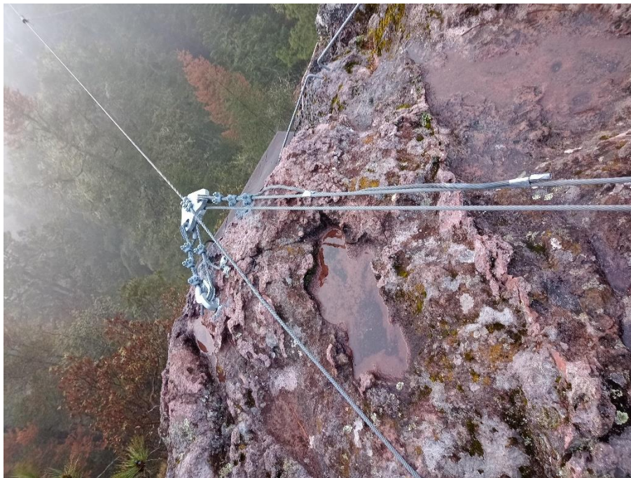
Imagen 34. Puntos de anclaje de la segunda tirolesa, sobre la roca.
