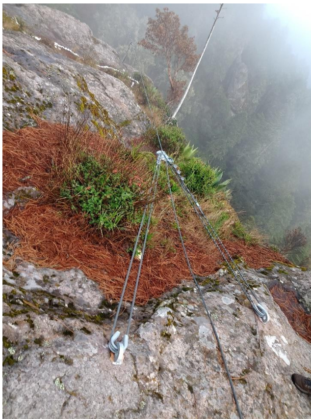
Imagen 32. Anclaje triple para cada tirolesa, sobre la roca
