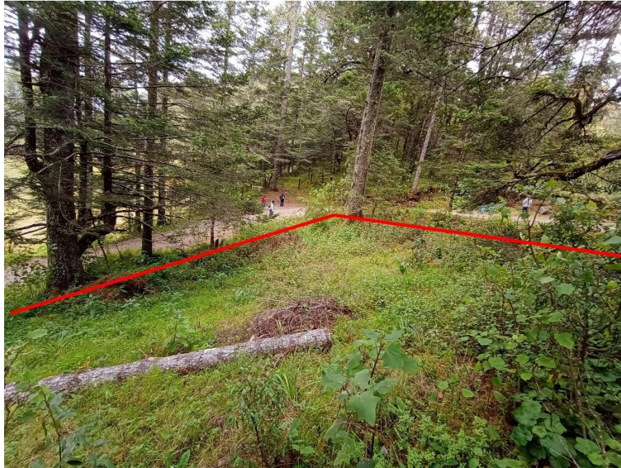
Imagen 36. Zona de construcción del estacionamiento y sanitarios.
