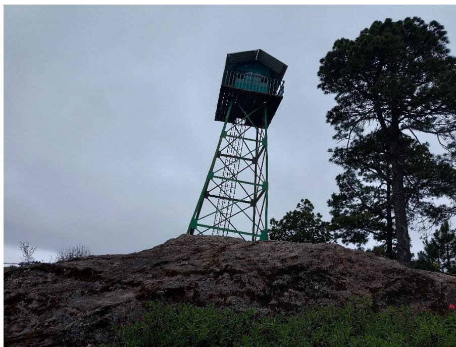
Imagen 16. Torre de observación existente.
