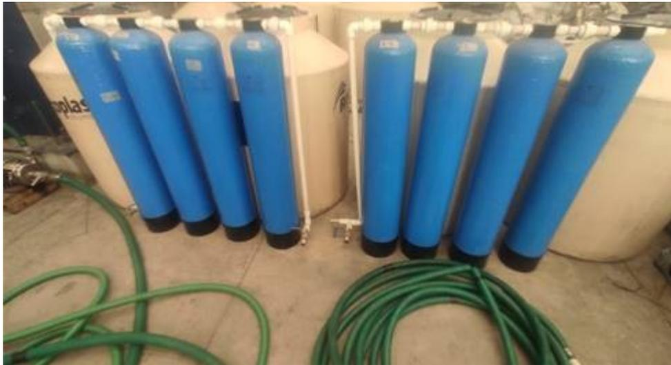
**Figura 24.** Tren de carbón activado
