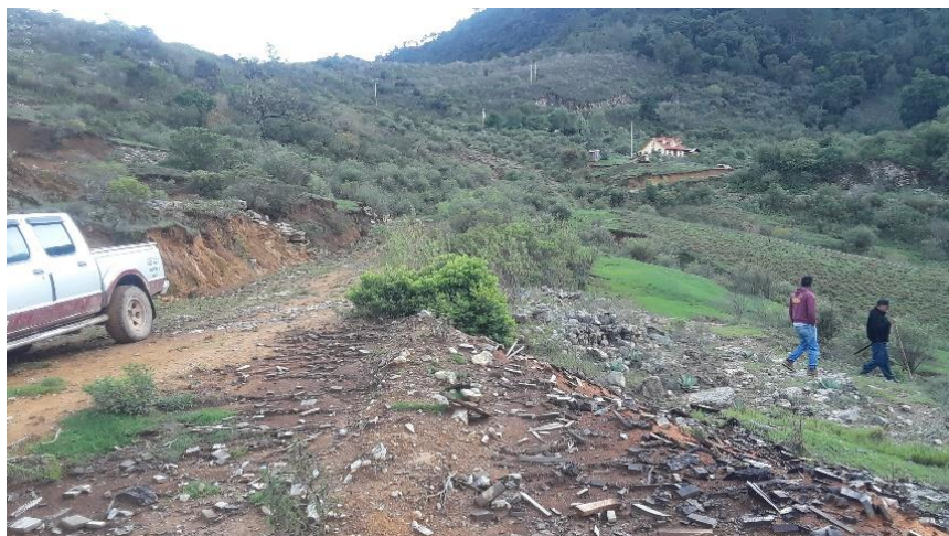
Imagen II.1 del camino existente de terracería que conduce a viviendas de la Col. Cabatiahua.
