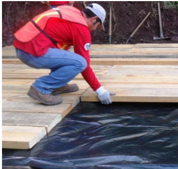
IMAGEN 2.13.-EJEMPLO DE LAS CUBIERTAS DE PLÁSTICO Y BASE DE MADERA QUE SE COLOCAN, PREVIO A LA COLOCACION DEL EQUIPO DE PERFORACIÓN.
