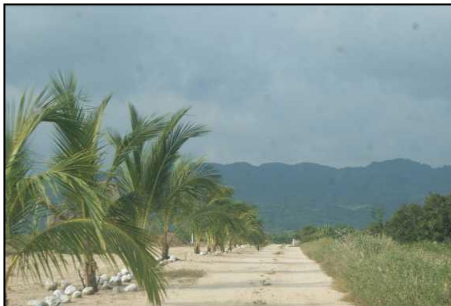
Fotografía 2. Vialidad principal revestida con cascajo, obra sancionada.
