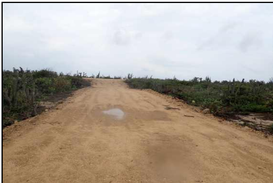
Fotografía 1. Vialidad al interior del predio, revestida con cascajo, obra sancionada por la PROFEPA.
