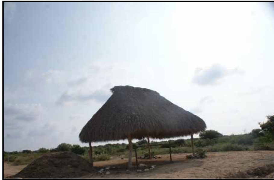
Fotografía 3. Palapa de acceso, obra sancionada.
