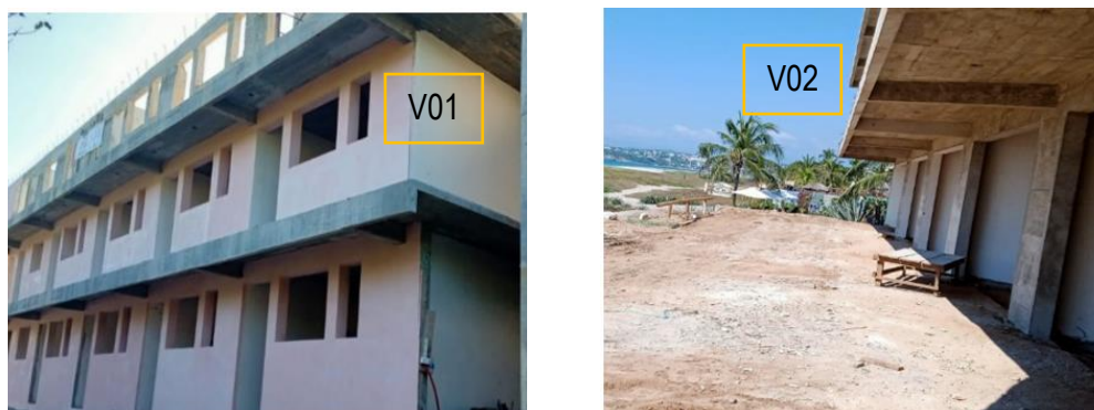
Figura 10. Volado (V01) y Volado (V02) del segundo y tercer nivel.
