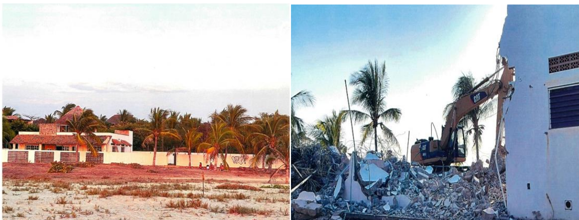
Figura 11. Construcción anterior y su proceso de demolición.
