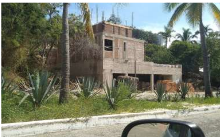
Construcción residencial unifamiliar en proceso de construcción dentro del sector
