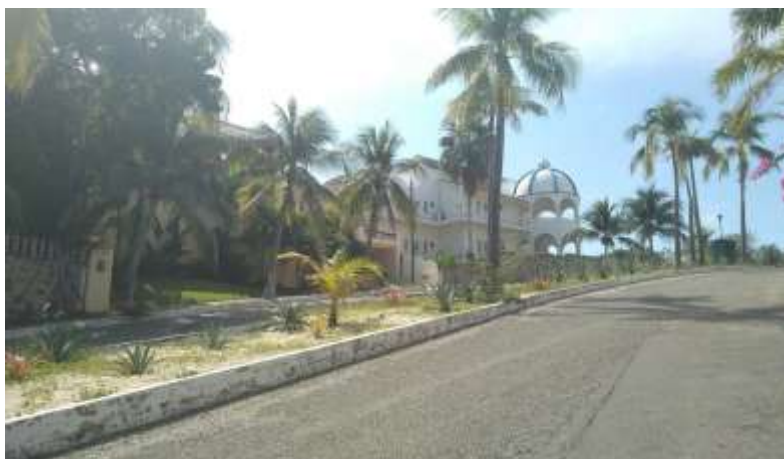
Construcción residencial unifamiliar en el sector
