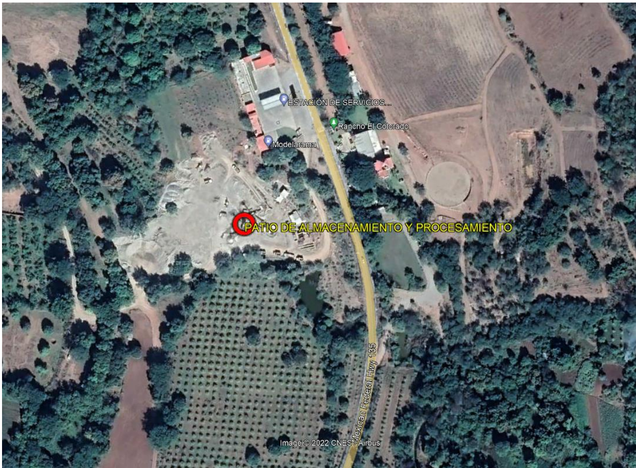
Figura 4 Fotografía satelital del patio de almacenamiento y procesamiento al que se trasladará el material.
