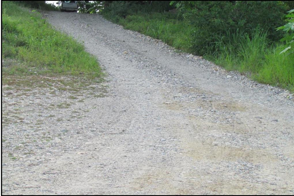
Fotografía 8. Condiciones del camino de acceso al río, el cual comunica con el patio de almacenamiento temporal del material extraído, y posteriormente con la carretera San Bartolo-Santa Teresa; dicho camino será revestido con material del mismo banco, para facilitar el rodamiento de los vehículos de carga y maquinarias.
