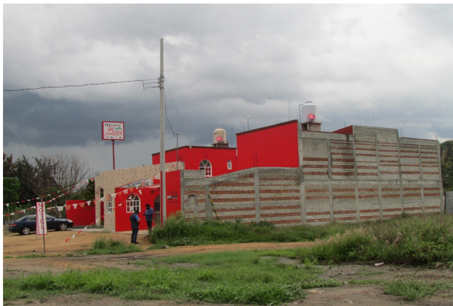
Fotografía 10. Vista Sureste del inmueble, nótase que la afectación a la zona es mínima, dado que el área cuenta con los servicios básicos necesarios.
