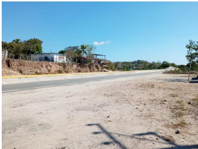
Figura 5. Camino de terracería para ingresar al pedio
