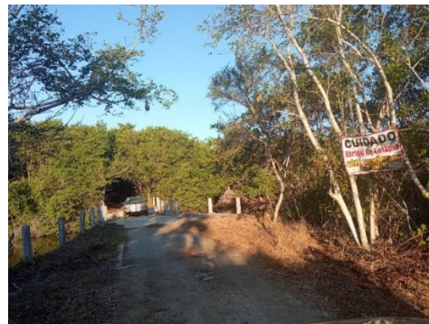
Figura 8. Puente que se encuentra en el camino principal de terracería.
