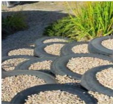
Juego para trepar hecho de llantas recicladas de 63 cm de diámetro y 40 cm de altura, fijada con varilla de 3/8" ahogada en dado de concreto colado en sitio  $f'c=200$  kg/cm<sup>2</sup>.
