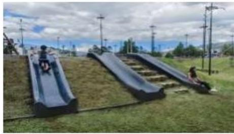
Resbaladilla de concreto armado colado en sitio  $f'c=200$  kg/cm<sup>2</sup>, con escalones de concreto colado en sitio  $f'c=200$  kg/cm<sup>2</sup> de 10 cm de espesor armado con malla electro soldada 6-6/10-10 y escalones a basa de llantas recicladas de 63 cm de diámetro y 40 cm de altura, fijada con varilla de 3/8" ahogada en dado de concreto colado en sitio  $f'c=200$  kg/cm<sup>2</sup>.
