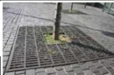
Alcorque de acero fabricado en sitio según diseño, con placa perforada de 3/16" con cortes a 45° de 2 a 3 cm, acabado de dos capas de primario MINIO y tres capas de esmalte alquidálico color gris caverna 314-06 (Comex). En estructura de PTR de 1 1/2" calibre 12 con ángulo de 1/2".
