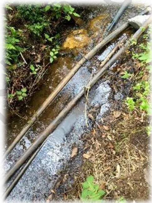
Fotografía 1. Derrame de hidrocarburo en el abastecimiento de agua.
