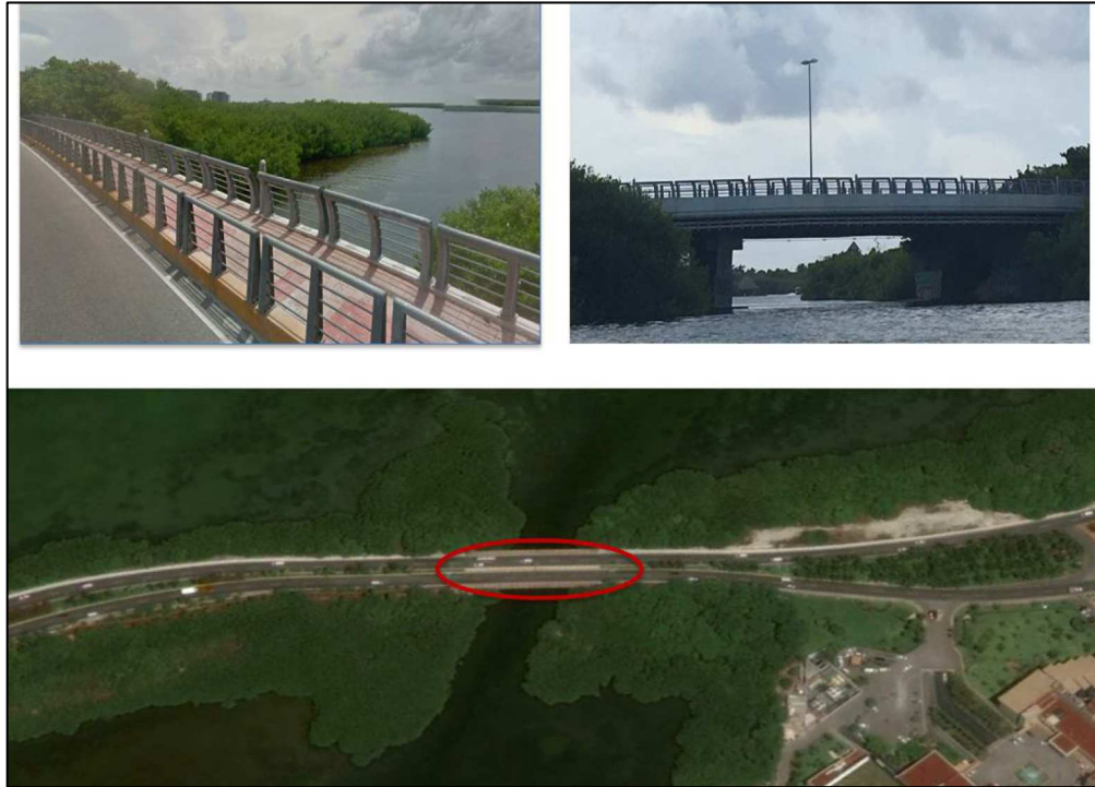
Ilustración 84. Puente Caleta (km 23) donde se fragmentó el mangle para dar paso al puente del boulevard Kukulcán, sin embargo, se aprecia que las unidades de mangle de borde crece de manera vertical.
