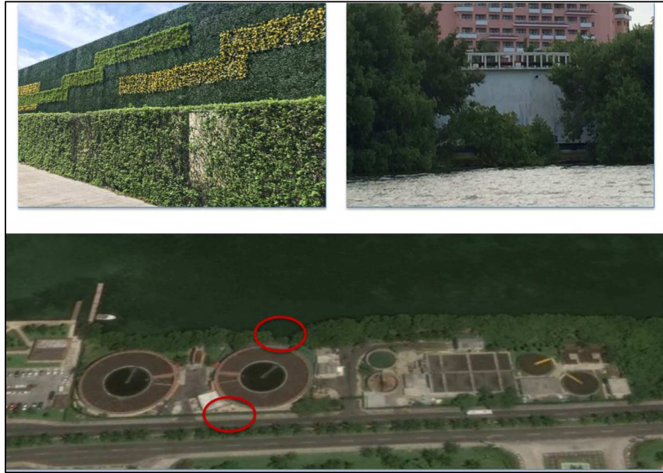
Ilustración 58. Planta de tratamiento de agua; donde se pueden observar unidades de manglar de borde que crecen de manera vertical y que el proyecto contiguo no afecta su crecimiento.
