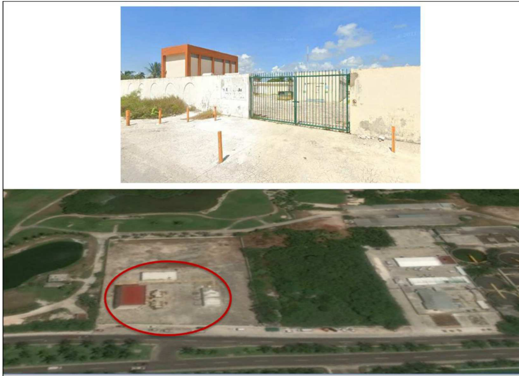
Ilustración 70. Instalaciones de la Comisión Federal de Electricidad (CFE).
