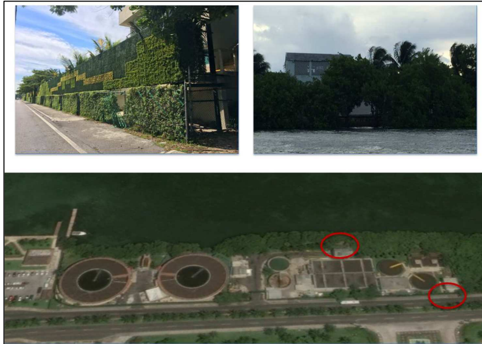
Ilustración 56. Planta de tratamiento de agua; donde se pueden observar unidades de manglar de borde que crecen de manera vertical y que el proyecto contiguo no afecta su crecimiento.
