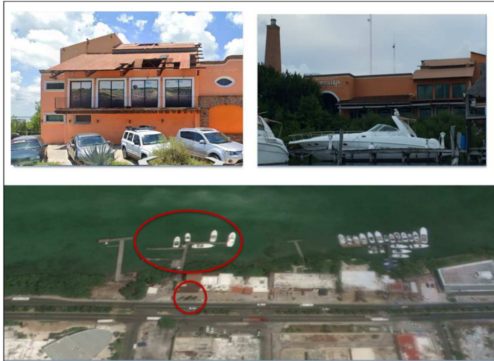
Ilustración 7. Sobre el boulevard; obra abandona. Sobre la laguna; obra abandonada, se puede observar unidades de manglar de borde que crecen de manera vertical y que el proyecto contiguo no afecta su crecimiento.
