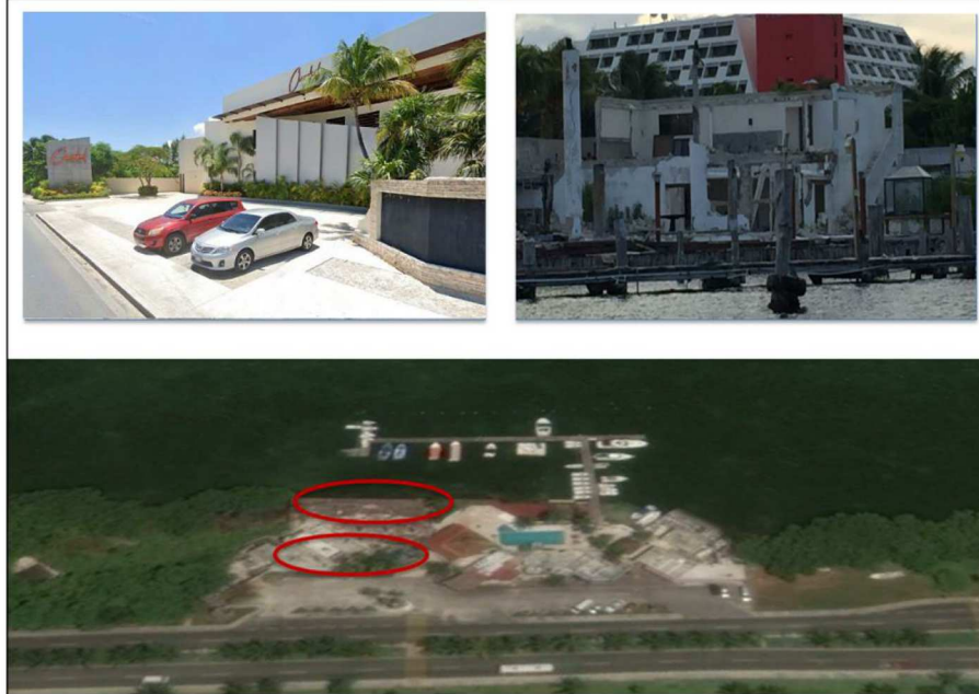
Ilustración 55. Sobre el boulevard, club Chicabal. Sobre la laguna, edificio abandonado.
