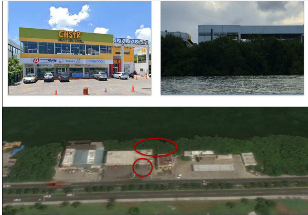
Ilustración 44. Sobre el boulevard; farmacia del ahorro y restaurante Cheester. Sobre la laguna; Plaza Zazil-Ha, donde se pueden observar unidades de manglar de borde que crecen de manera vertical y que el proyecto contiguo no afecta su crecimiento.
