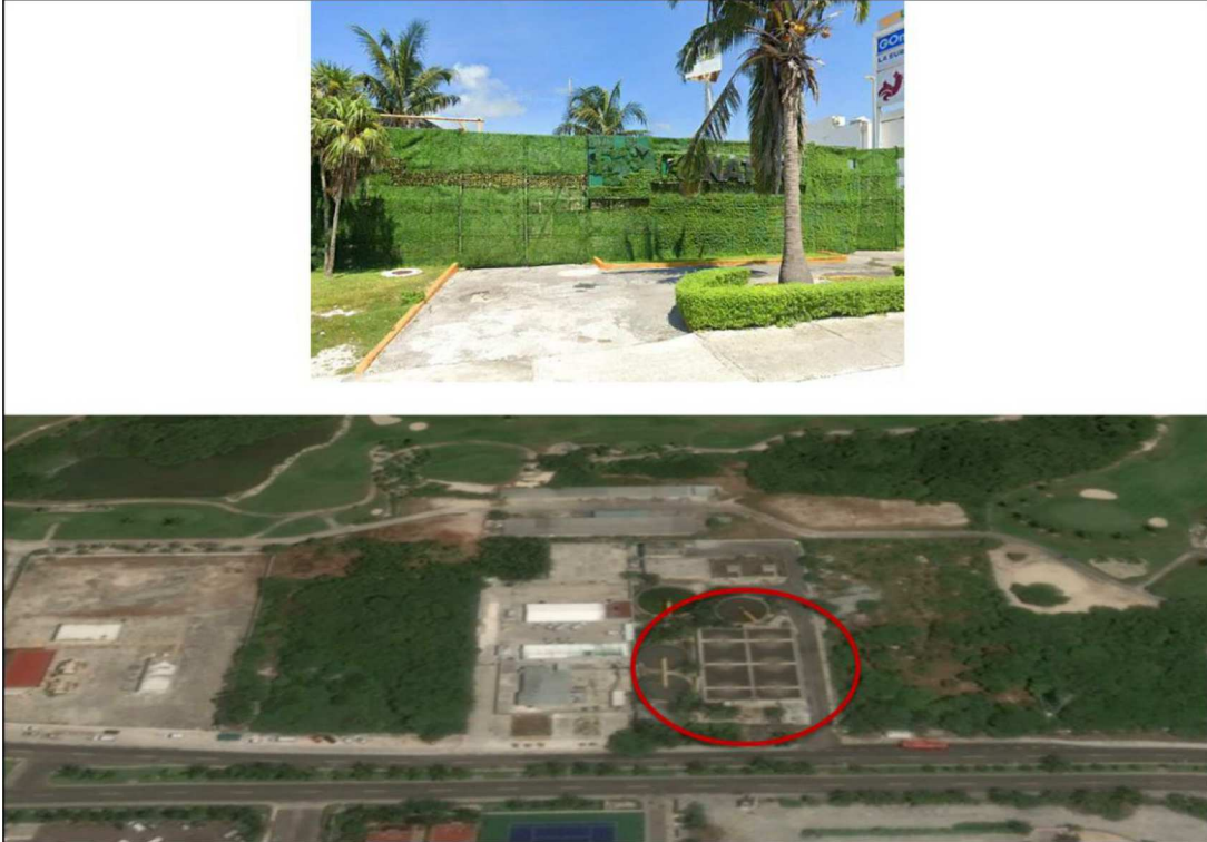
Ilustración 68. Planta de tratamiento de agua.
