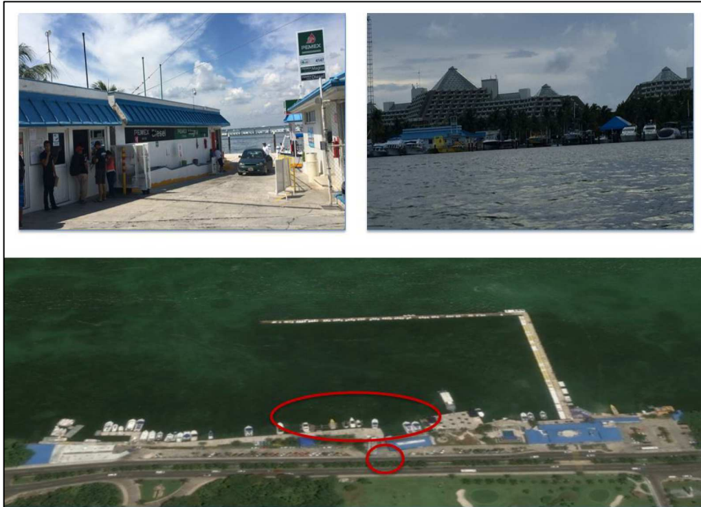
Ilustración 50. Aquaworld y gasolinera exclusivamente marítima de PEMEX.
