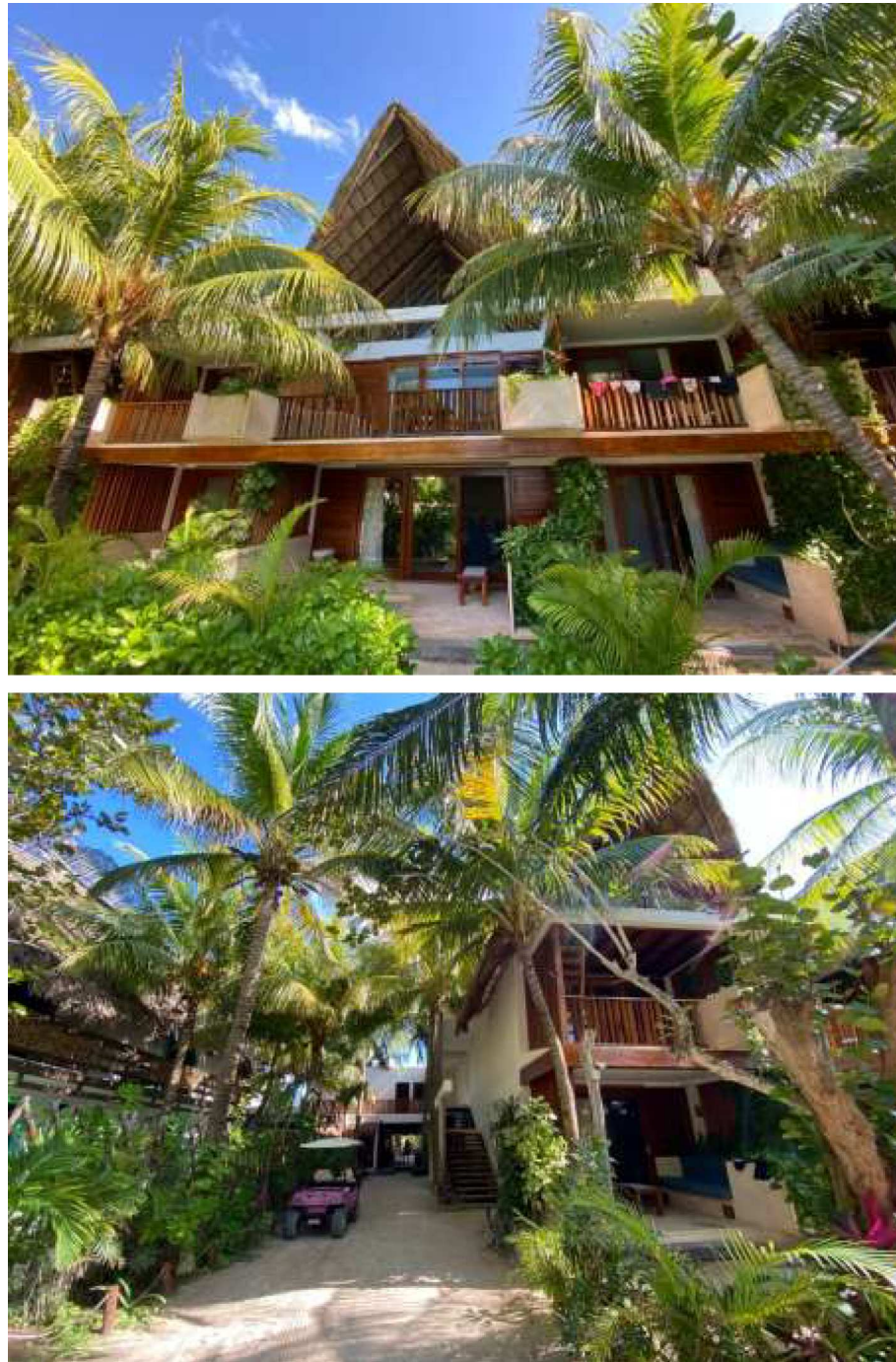
Figura 4. Condiciones actuales del Edificio principal.
