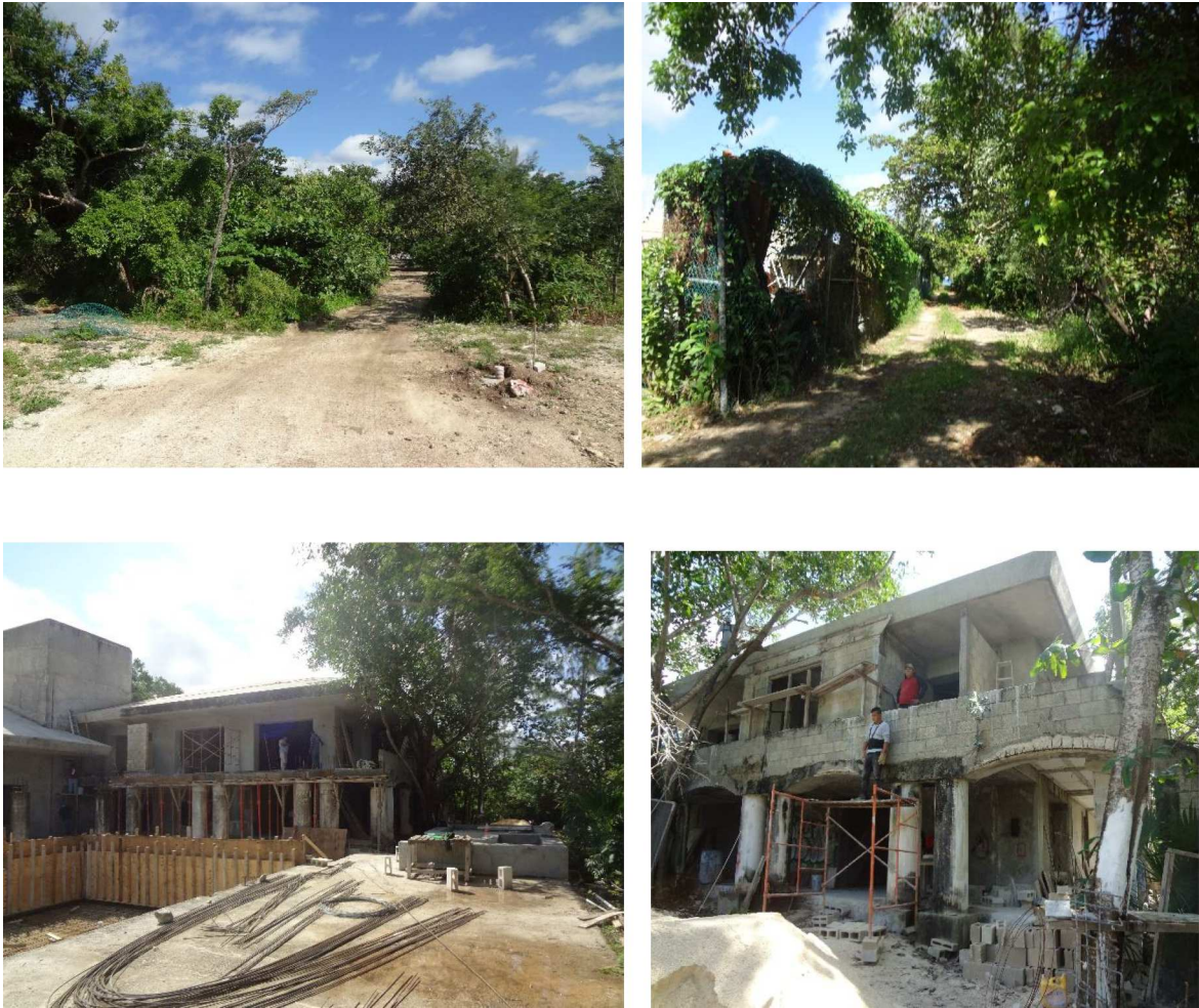
Figura 4. Caminos de acceso a la Villa 1 y remodelación de la casa existente.
