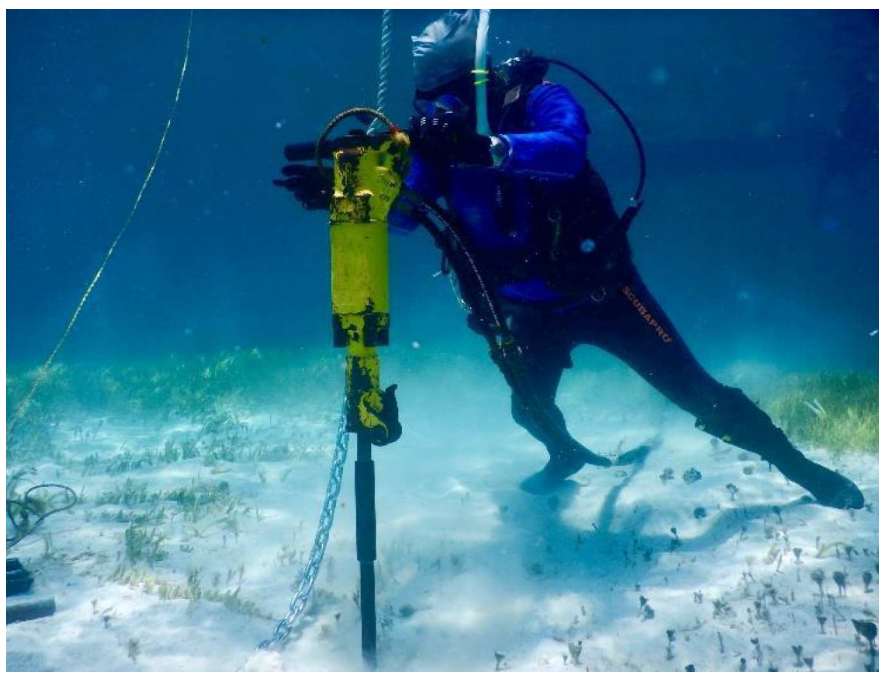
Figura 4.- hundimiento del anclaje manta raya con un martillo hidráulico.
