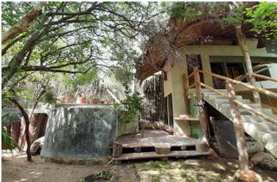
Baños, depósitos y paneles solares
