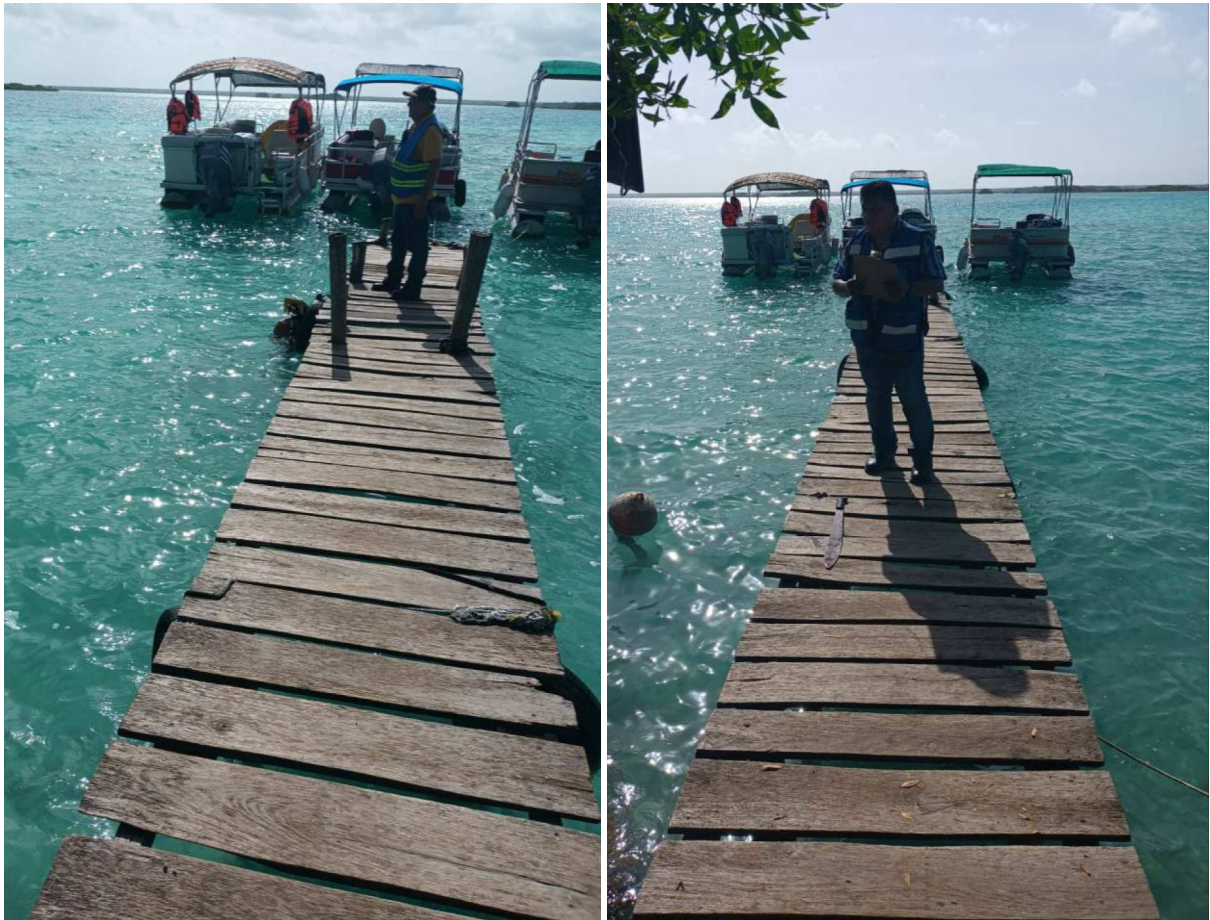
Figura 4.- Imágenes recientes del muelle de madera que nos ocupa.
