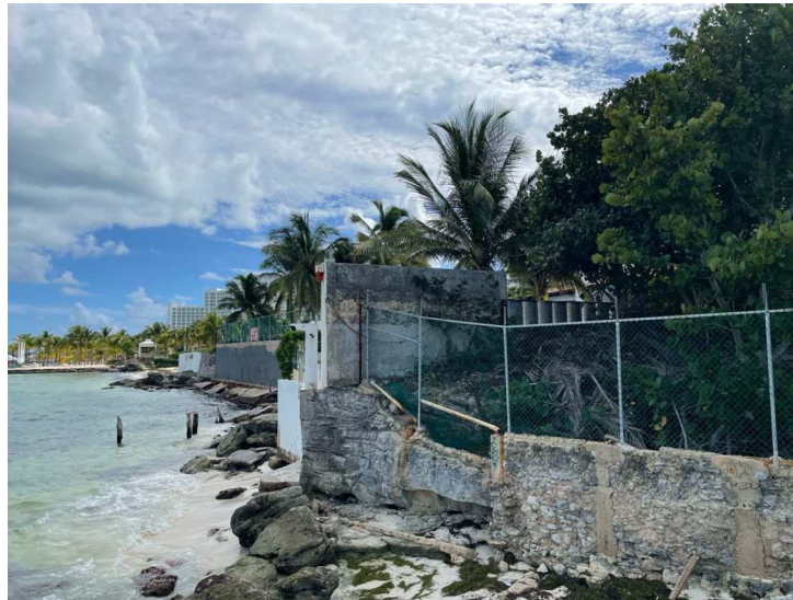
Figura 12: Frente de playa. Hacia el este del predio se localiza una casa residencial de 3 niveles y zona hotelera.
