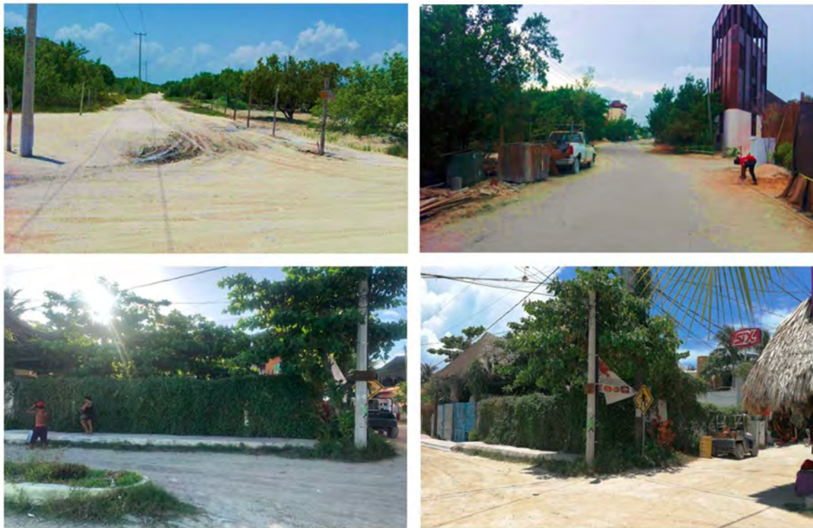
Figura 10 infraestructura observada en la zona
