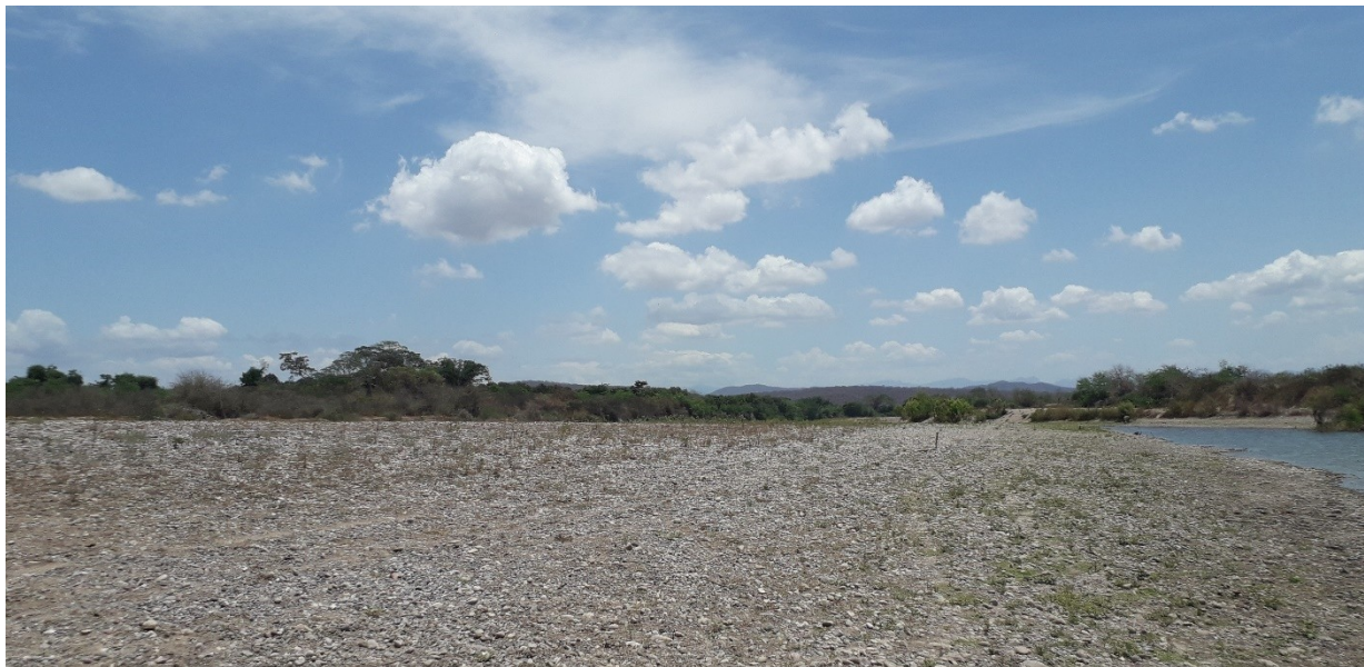
Fotografía No. 1. Vista panorámica del área del proyecto.
