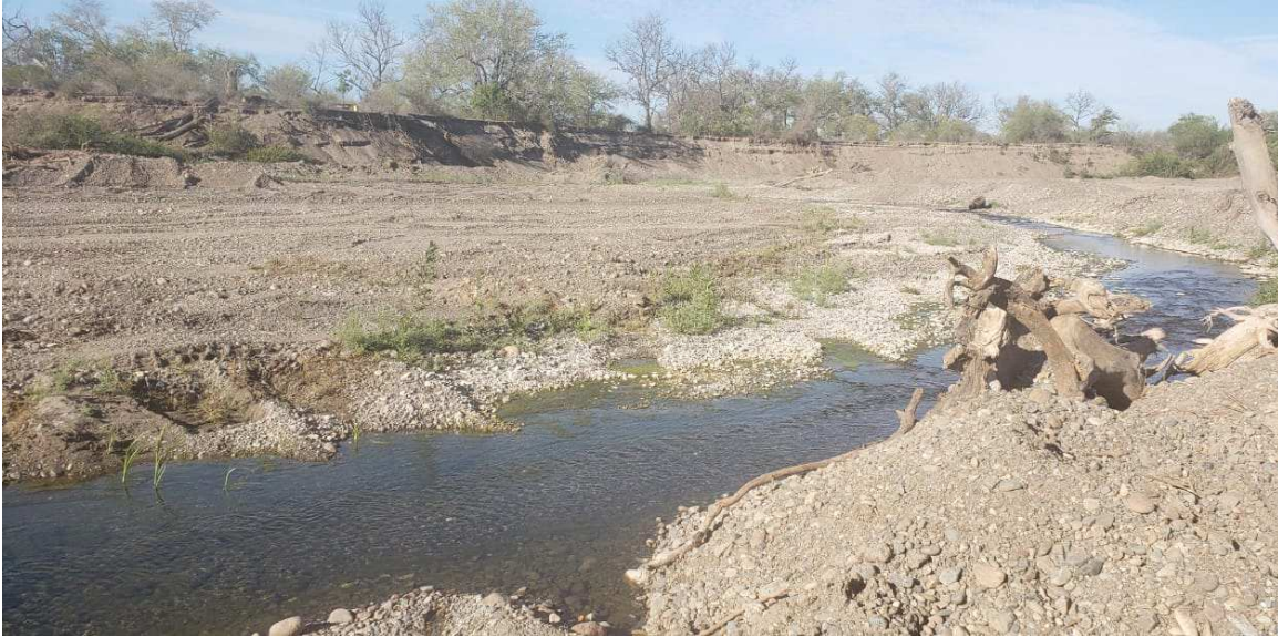
Fotografía No. 7. Debido la erosión de los taludes se observa troncos obstruyendo el cauce del río.
