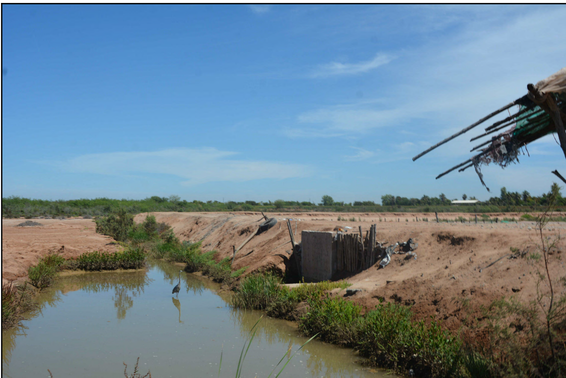
Estanquería y drenes en la granja acuícola Mi Cielo.
